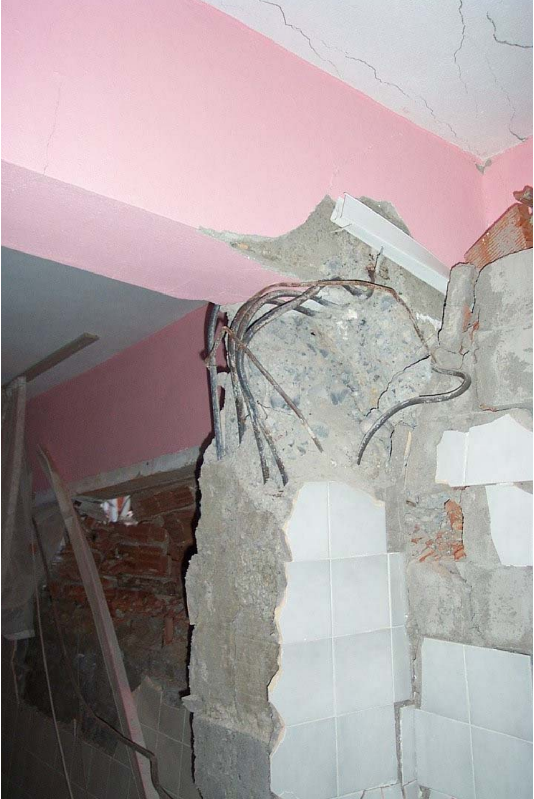
Donatı Kusurları (Kolon-Kiriş bağlantı hataları)
