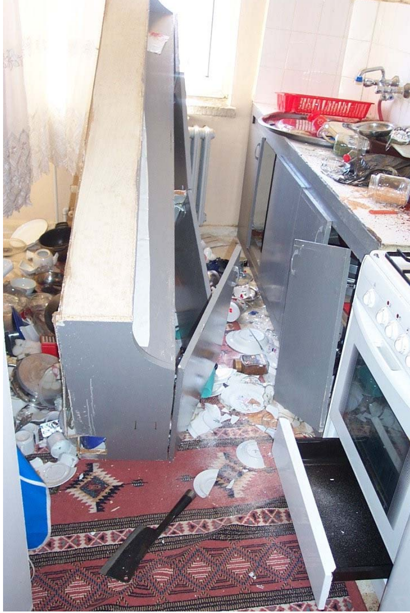
Mutfak dolaplarının bağlantılarının kopması
