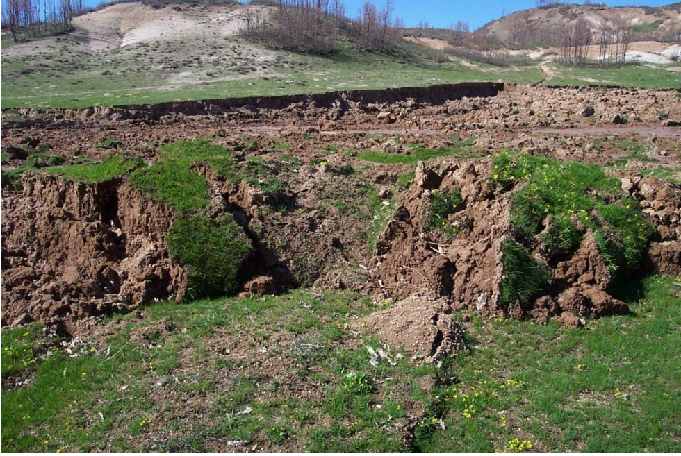
Deprem nedeni ile oluşan yeraltı suyu basıncının etkisiyle oluşmuş çökmeler ve çamur akmaları
